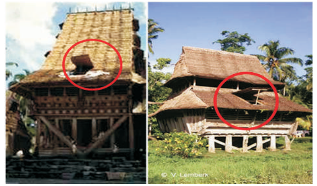
Gambar 20. Ventilasi ( sky light ) Atap Rumah Adat Nias Utara (Sumber: Lemberk, 2012)
